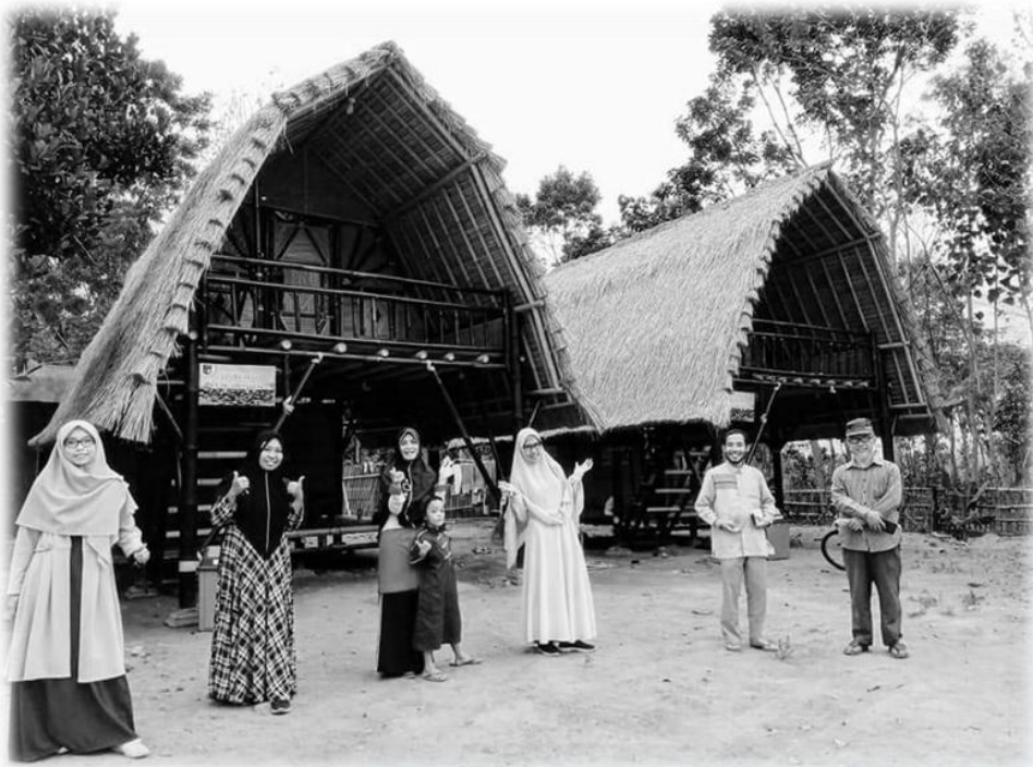
Gambar 16.1 Gedung SMAIT Cahaya Bangsa Lombok. Sumber: Dokumen SMAIT Cahaya Bangsa Lombok.
