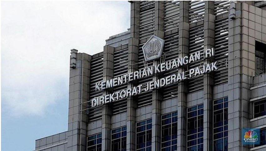
Gambar 9.4 Penampakan Gedung Direktorat Jenderal Pajak (Sumber: www.cnbcindonesia.com )
