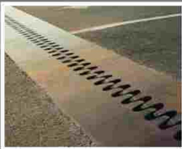
Gambar 125. Persambungan Ekspansi Termal Pada Jembatan
