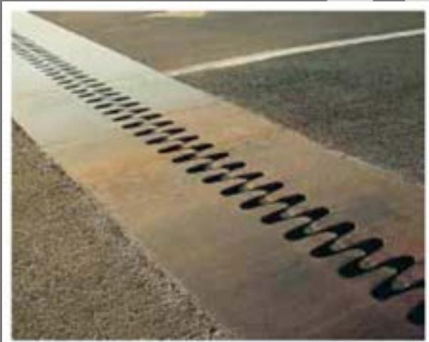
Gambar 125. Persambungan Ekspansi Termal Pada Jembatan
