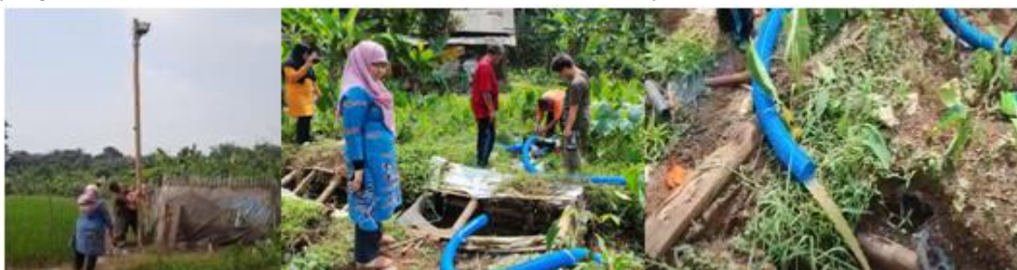
Gambar 7. Pemasangan Alat Pemberdayaan Masyarakat dan pemasangan Lampu PJU
