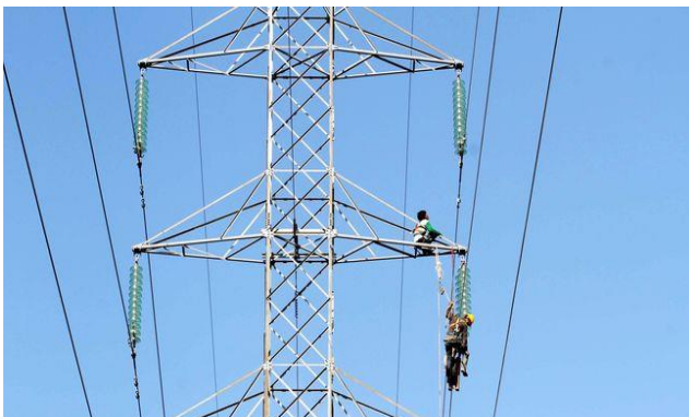
Gambar 7.24: Menara SUTET sebagai transmisi listrik
