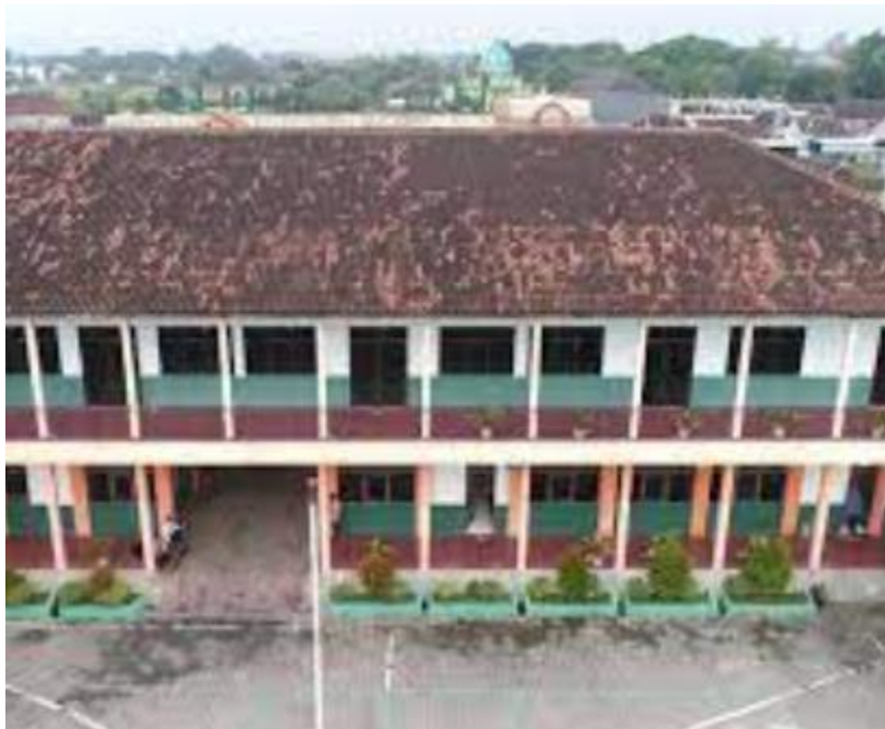
Gambar 1. Gedung SMK Tunas Muda Unggul Banten
