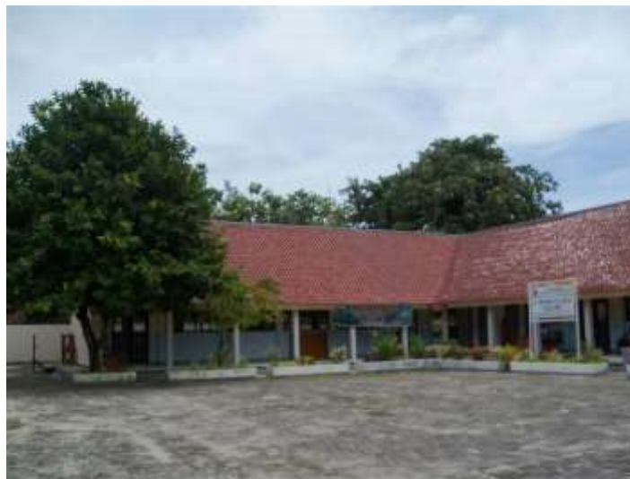
Gambar 1 Fasilitas Sekolah di Pulau Pari
