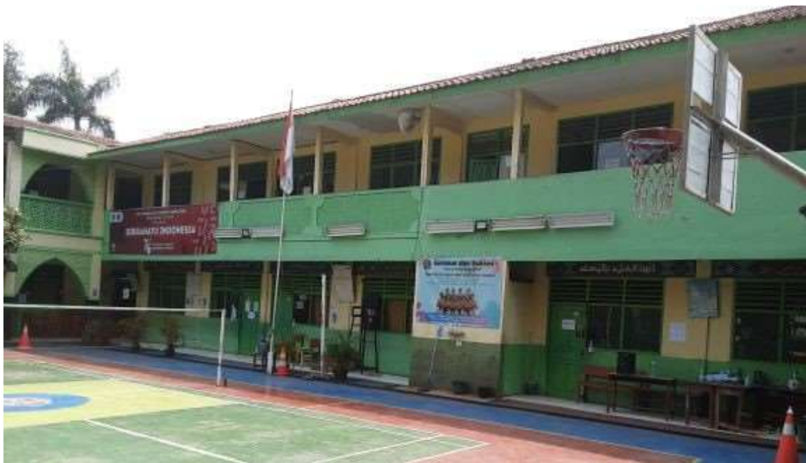
Gambar 2. Gedung Sekolah SMP Islam Raudlatul Hikmah, Pamulang. (Sumber: Dokumentasi Pribadi)
