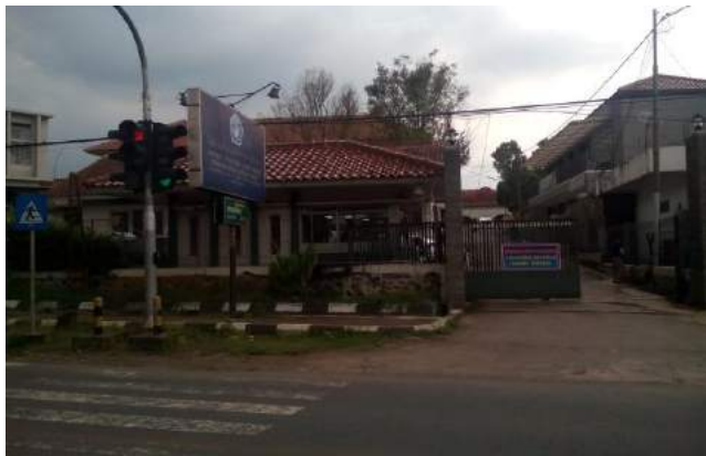
Pintu Gerbang Pesantren Darul Arqam Garut
