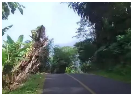
Gambar 2. Kondisi Jalan Menuju Kecamatan Cidaun, Cianjur Selatan
