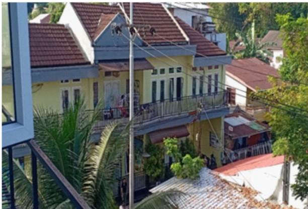
Gambar VIII.9. Lahan Tempat TK ABA II di Jalan Ponegoro Setelah Kerusakan yang Kini Menjadi Warung Makan dan Rumah Tinggal
