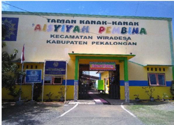
Gambar IV.24. Pintu Masuk Bangunan Depan TK ABA 1 Gumawang
