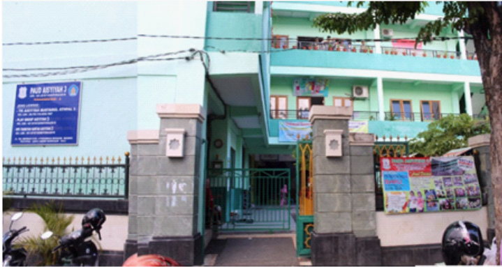
Gambar V.6. Bangunan TK ABA 3 Denpasar
