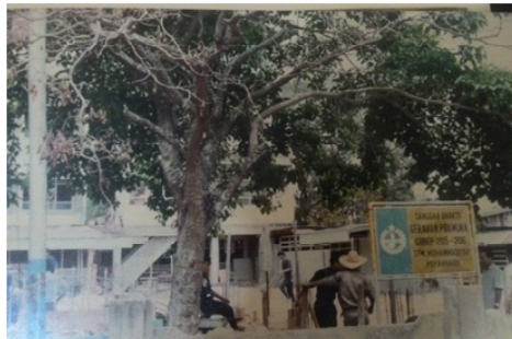
Gambar III.26. Proses Pembangunan STM Muhammadiyah Setelah TK 'Aisyiyah 1 Dipindahkan Ke Jalan Angkasa
