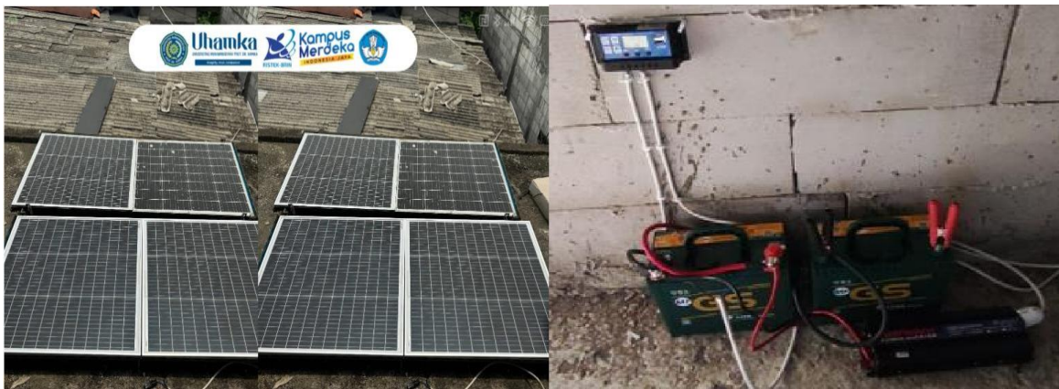
Gambar 7. Panel surya dan perangkatnya sebagai sumber penggerak sistem alat pelontar pakan ikan
