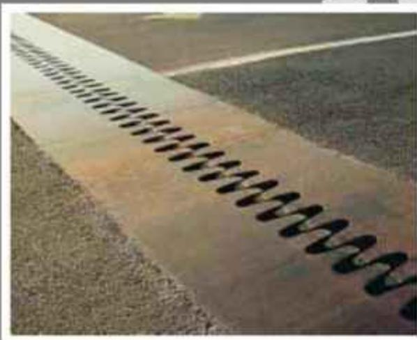
Gambar 125. Persambungan Ekspansi Termal Pada Jembatan
