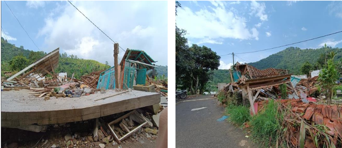
Gambar 1. Kondisi rumah penduduk terkena gempa bumi Cianjur
