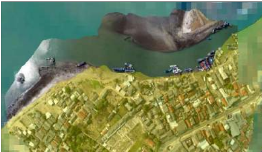
Gambar 4.20. Area terkena tsunami lokasi pemukiman di Desa Panimbangjaya
