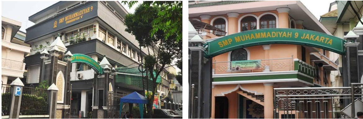
Gambar 4 Gedung SMP Muhammadiyah 9 Limau
