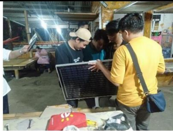
Gambar 4 pemasangan penerangan solar cell
