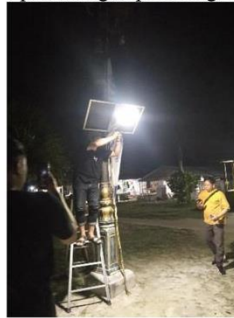
Gambar 5 Pemasangan Penerangan solar cell di pulau pari
