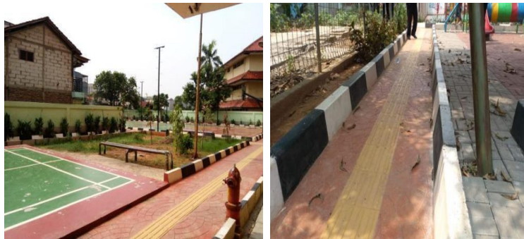
Guiding blok di area lapangan olahraga Rusunawa Flamboyan Sumber; Dokumentasi Peneliti
