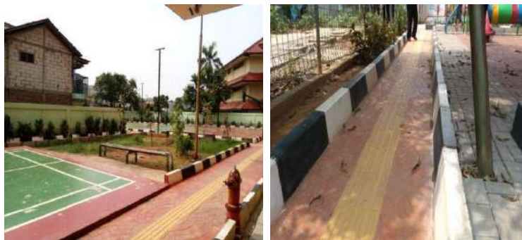
Guiding block di area lapangan olahraga Rusunawa Flamboyan Sumber; Dokumentasi Peneliti
