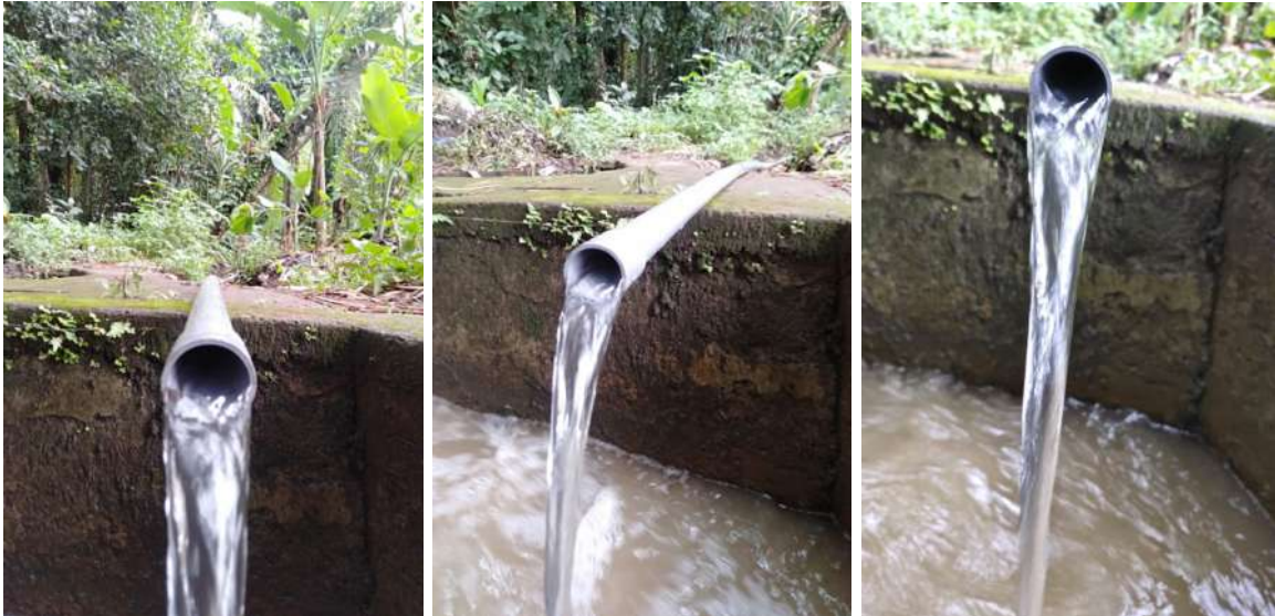
Gambar 4. Hasil debit air dari pompa dialirkan ke saluran irigasi subak
