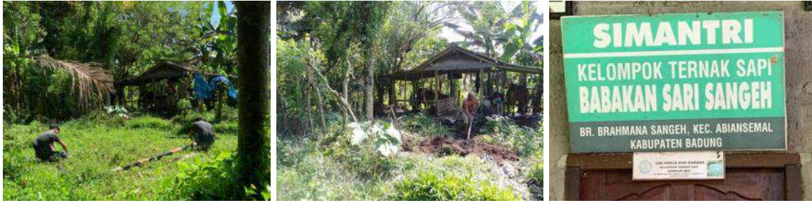
Gambar 1. Lokasi yang akan dibangun PLTS dan proses pembersihan lahan
