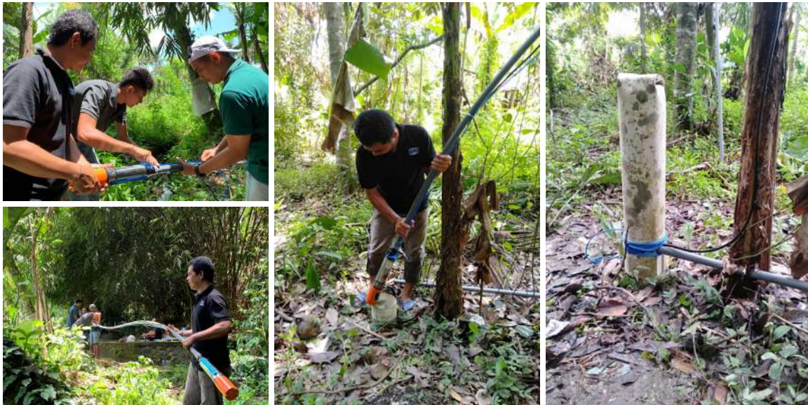
Gambar 3. Pemasangan pompa submersible ke dalam sumur bor
